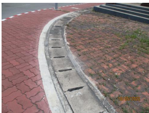
รูปที่ 2-9 รางระบายน้ำเพื่อรวบรวมน้ำส่งไปยัง ระบบบำบัดน้ำเสียส่วนกลาง
